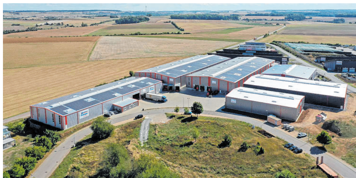
Der fertiggestellte Gesamtkomplex auf der Tauberhöhe aus der Vogelperspektive, Blickrichtung Bronn/Pfützingen.
